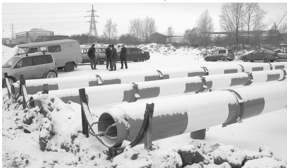
За качеством всех работ на строительной площадке ведётся строгий контроль.
