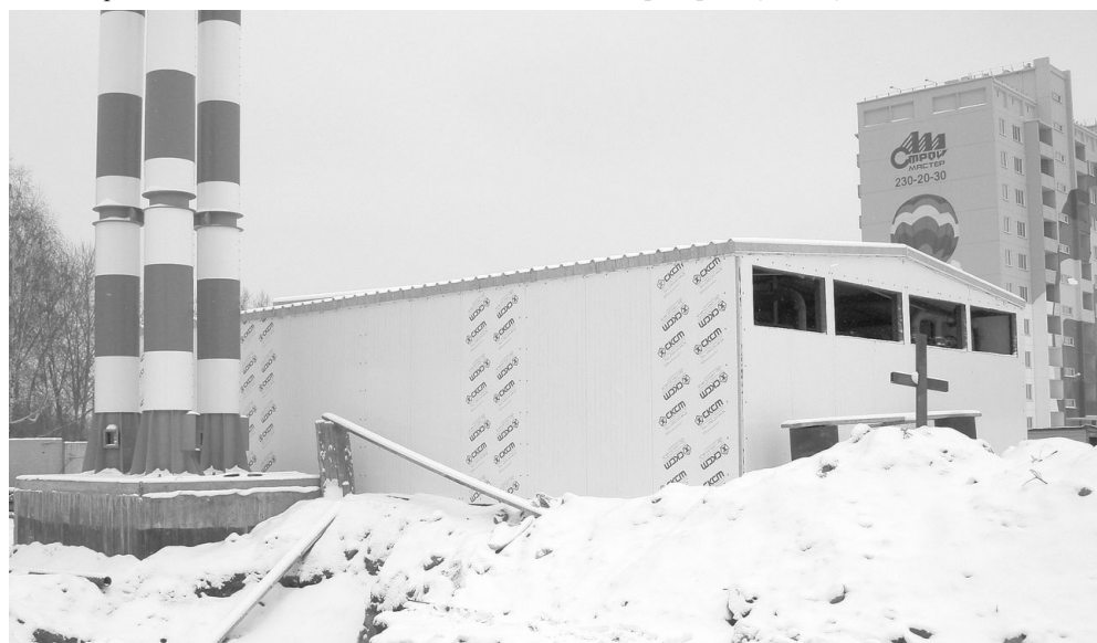
Для жилья больше подходят кирпич и дерево, а для нежилых зданий — металлокаркас и сэндвич-панели.
